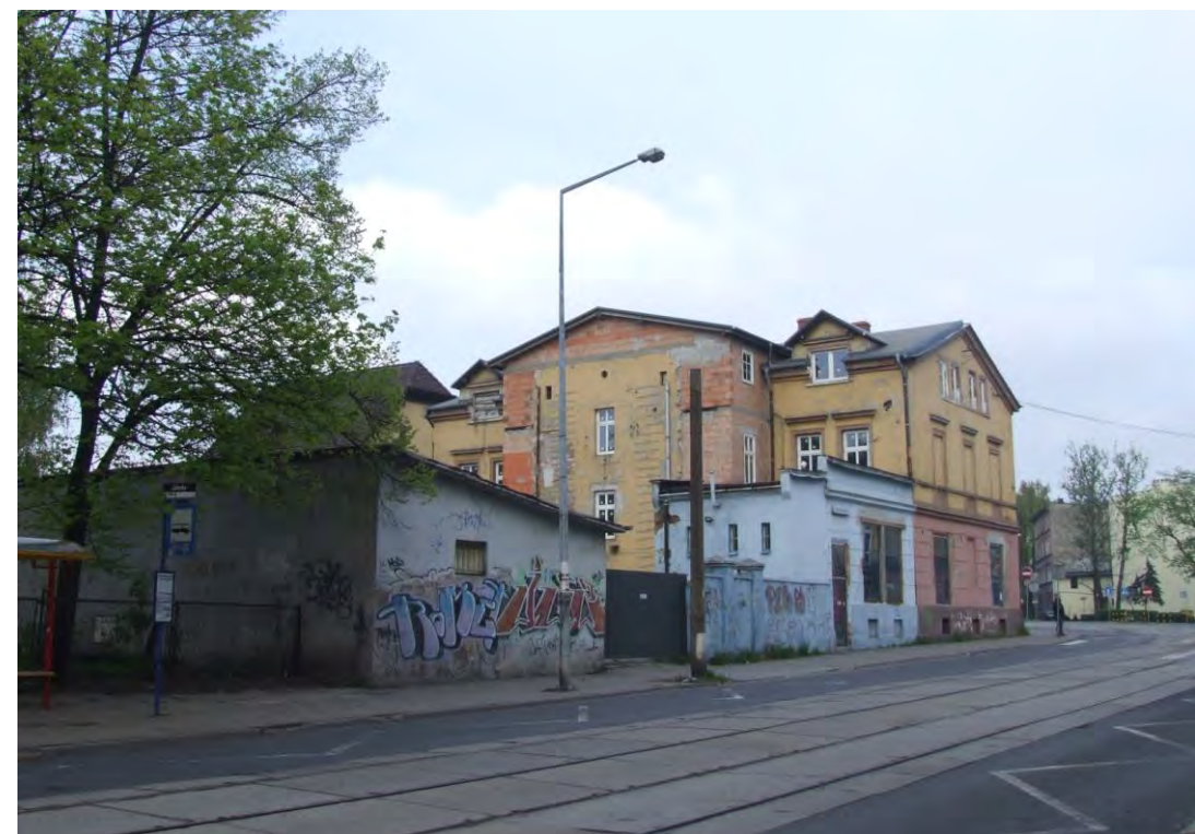
STAN PRZED PRZEBUDOWĄ
